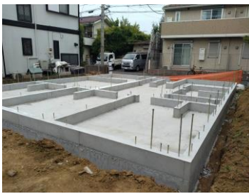
基礎工事の様子
